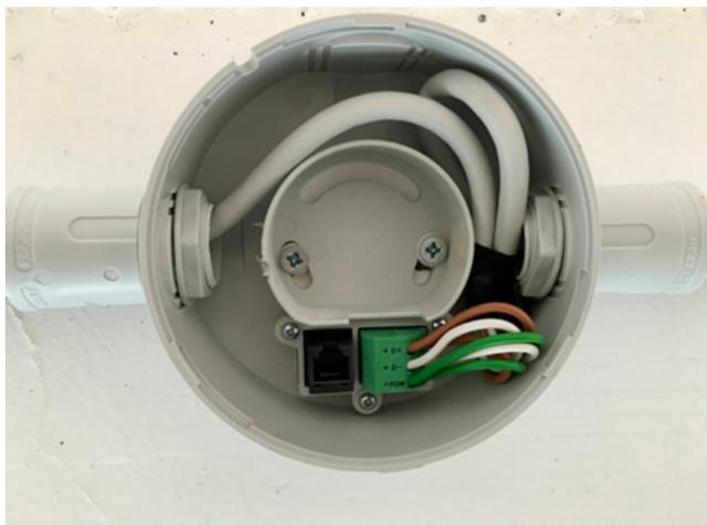
Coloque el cable alrededor de la parte interior de la base para evitar daños en el aislamiento del cable.
