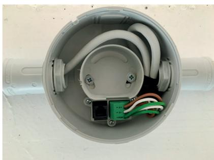
**Fig. 4** Coloque el cable alrededor de la parte interior de la base para evitar daños en el aislamiento del cable.
